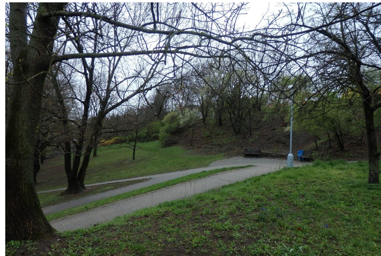
Spojnice tří parkových cest pod propustkem
