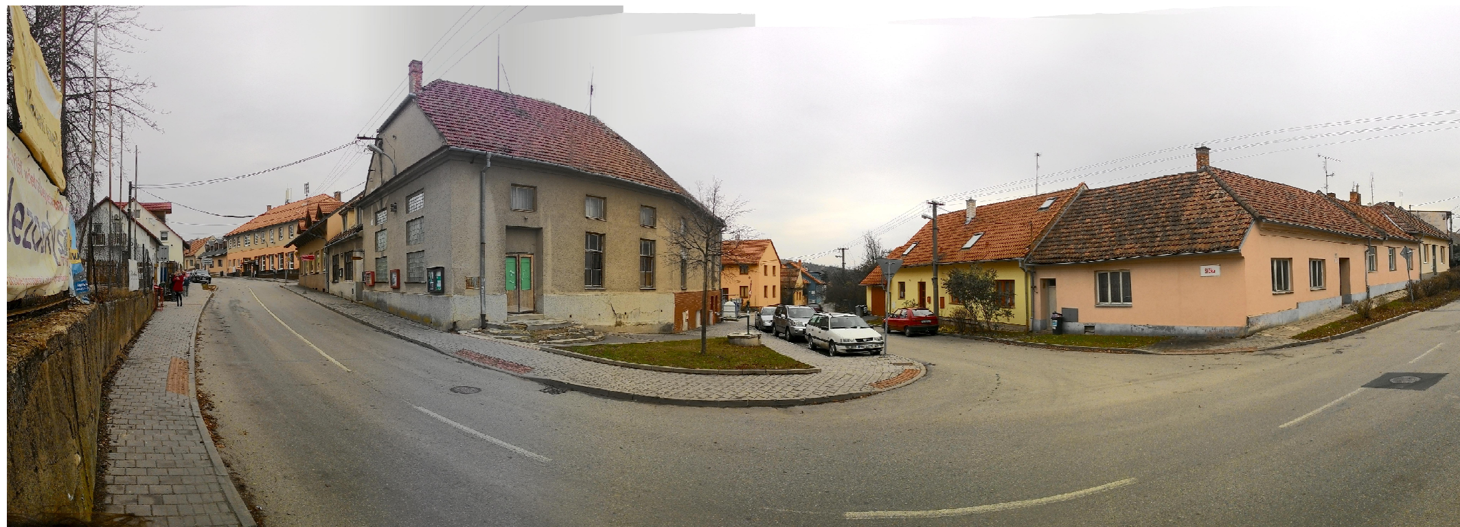
chybějící nebo úzké chodníky, stávající zárubní zeď narušena vlhkostí, budova Sokolovny v havarijním stavu
