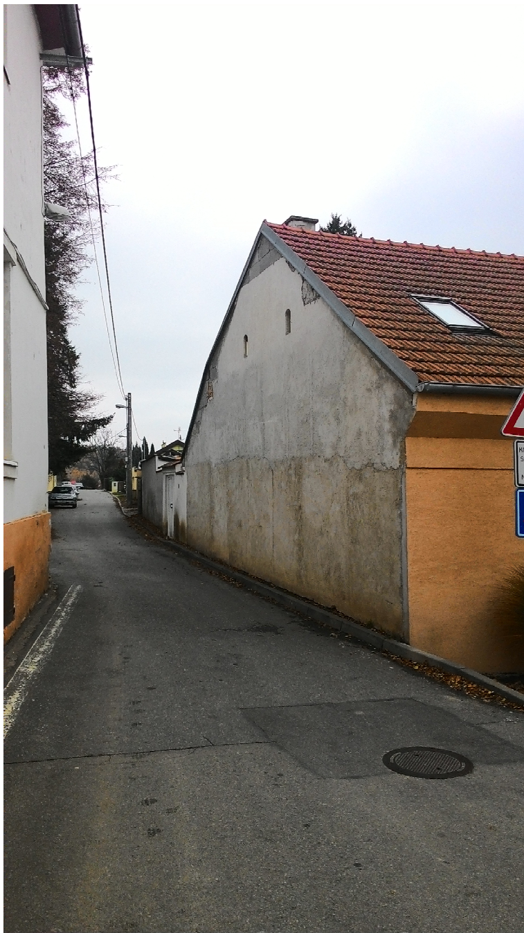
zúžený profil ulice Rozárka - kolizní úzký průjezd
