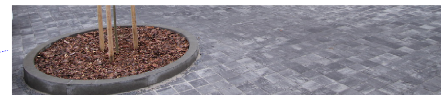
PŘÍKLAD BETONOVÉ DLAŽBY A BETONOVÉHO OBRUBNÍKU KOLEM STROMU
