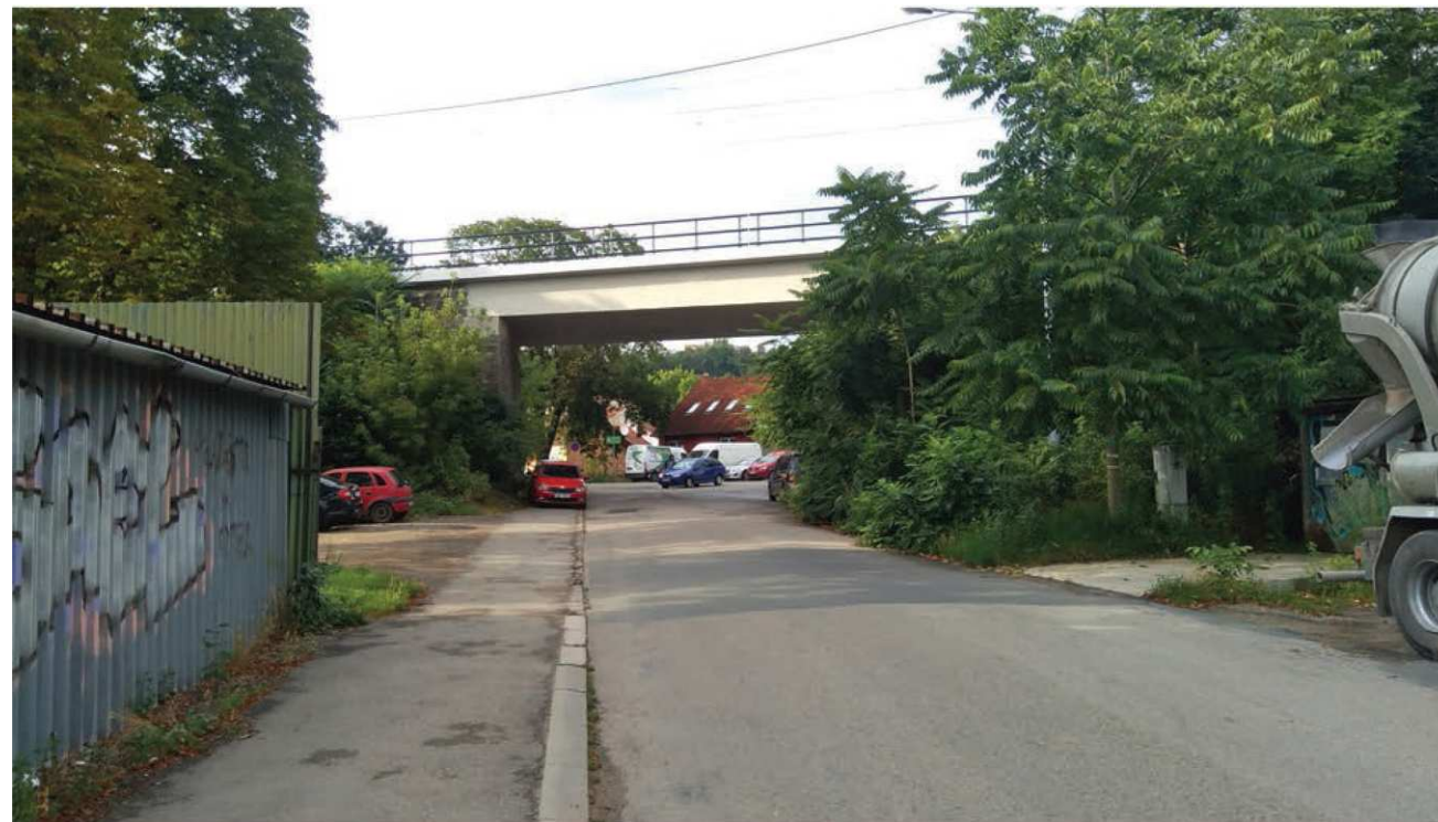
Vstup do Divišovy čtvrti - pohled ul. Trtílkovou na podjezd pod železniční tratí od jihu, v zakončení průhledu parkující auta
