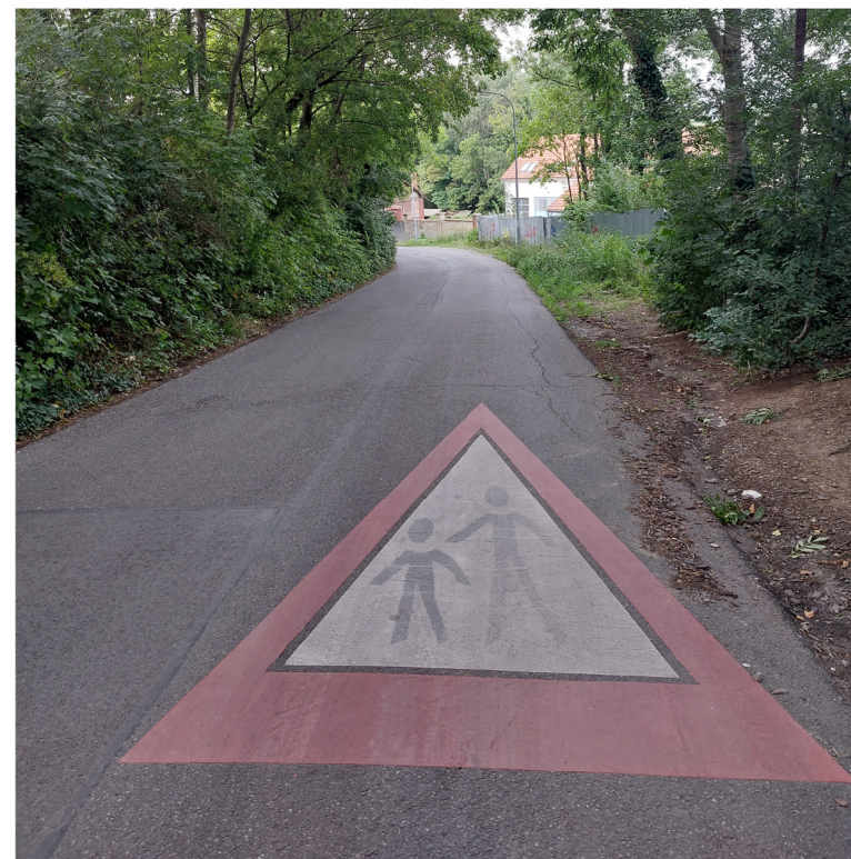
pohled k severu na svažující se ul. Cacovickou od křižovatky s ul. Skryjovou; chybějící chodníky, komunikace odvodněna do přilehlého terénu
