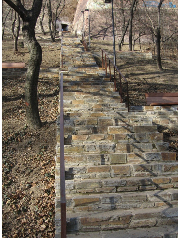
"stupně na terénu" - krátká zkratka svahem s několika lavičkami a s výhledem do údolí Svitavy; stupně vytvářejí pobytové / odpočinkové místo uprostřed svahu; šířka stupňů 2 m, postranní vyhlídkové podesty s dřevěnými lavičkami
