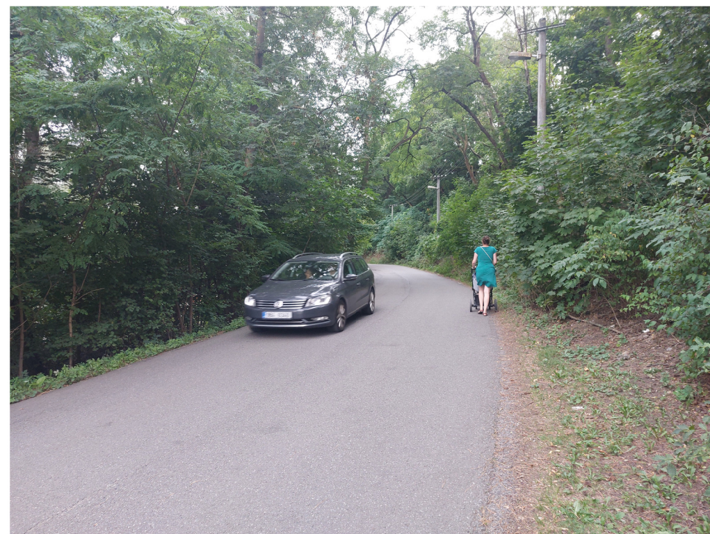
pohled k jihu na ul. Cacovickou; chybějící chodníky, komunikace odvodněna do přilehlého terénu;
