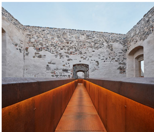
"lávka svahem" a "lávka na ostrov" - příklady řešení architektonického výrazu lávek pro pěší a cyklisty; příklad mozaiky z pororoštů na pochozí mostovce; pororošt je protiskluzný, jednoduše řeší odvodnění mostovky a umožňuje růst vegetace pod lávkou; příklad řešení: Kadaň, ČR
