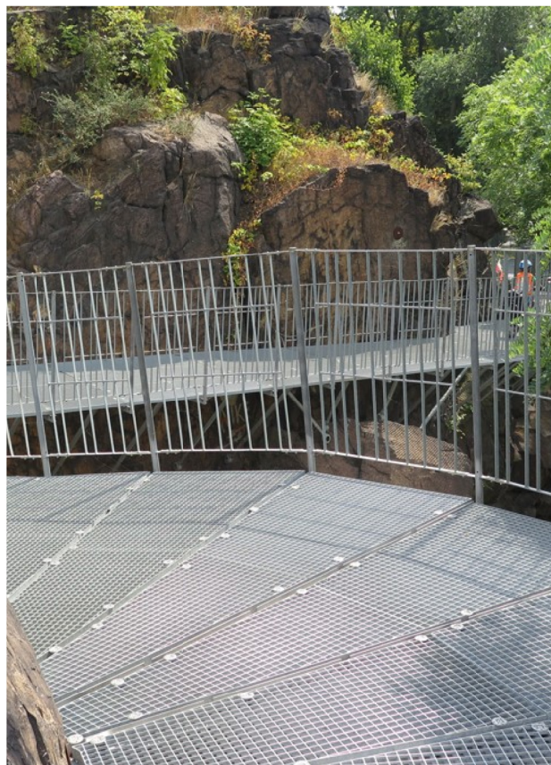
"lávka svahem" a "lávka na ostrov" - příklady řešení architektonického výrazu lávek pro pěší a cyklisty; příklad mozaiky z pororoštů na pochozí mostovce; pororošt je protiskluzný, jednoduše řeší odvodnění mostovky a umožňuje růst vegetace pod lávkou; příklad řešení: Kadaň, ČR
