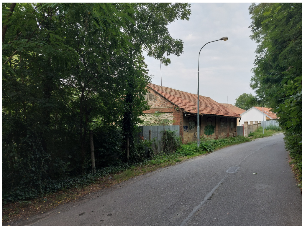
pohled k jihu na ul. Cacovickou v místě budoucího přechodu pro chodce a cyklisty; vlevo místo budoucího napojení lávky na Cacovický ostrov cihelňný objekt je na p.č. 2397/15;
