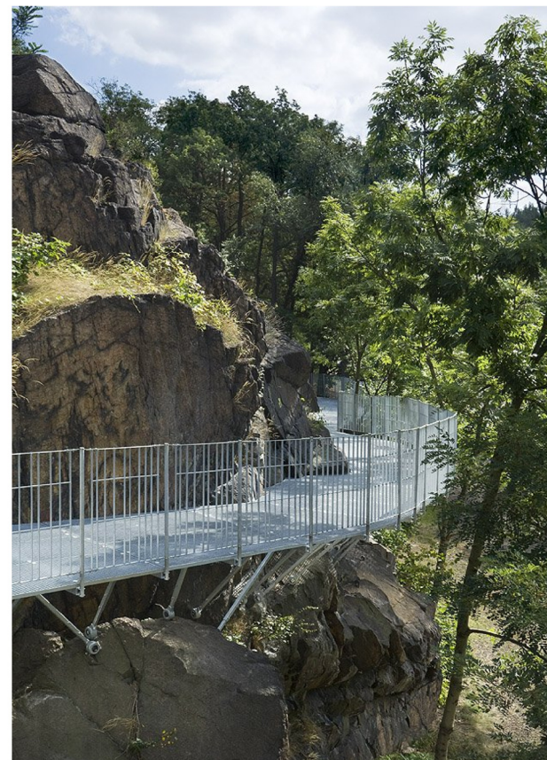
"lávka svahem" a "lávka na ostrov" - příklady řešení architektonického výrazu lávek pro pěší a cyklisty; příklad mozaiky z pororoštů na pochozí mostovce; pororošt je protiskluzný, jednoduše řeší odvodnění mostovky a umožňuje růst vegetace pod lávkou; příklad řešení: Kadaň, ČR
