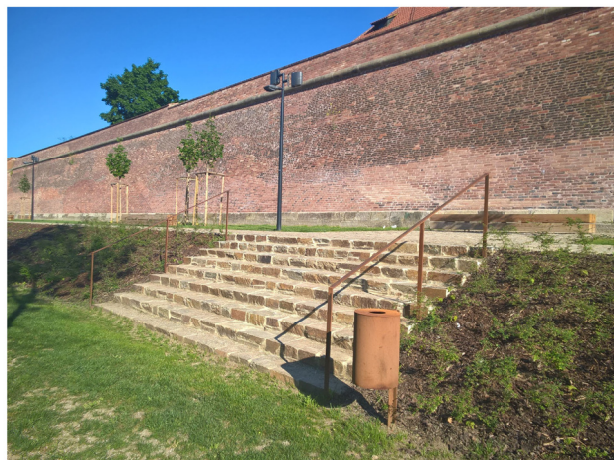
"stupně na terénu" - krátká zkratka svahem s několika lavičkami a s výhledem do údolí Svitavy stupně z místního lomového kamene, s řezanou nášlapnou plochou vhodně zapadají do přírodního prostředí lokality; kortenové detaily (zábradlí, odpadkový koš) navazují na materiálové řešení pěší lávky svahem příklad řešení: Praha 2, ČR
