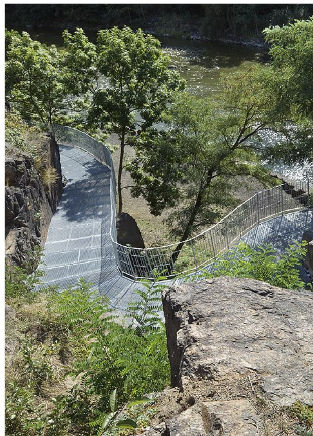
"lávka svahem" a "lávka na ostrov" - příklady řešení architektonického výrazu lávek pro pěší a cyklisty; příklad mozaiky z pororoštů na pochozí mostovce; pororošt je protiskluzný, jednoduše řeší odvodnění mostovky a umožňuje růst vegetace pod lávkou; příklad řešení: Kadaň, ČR
