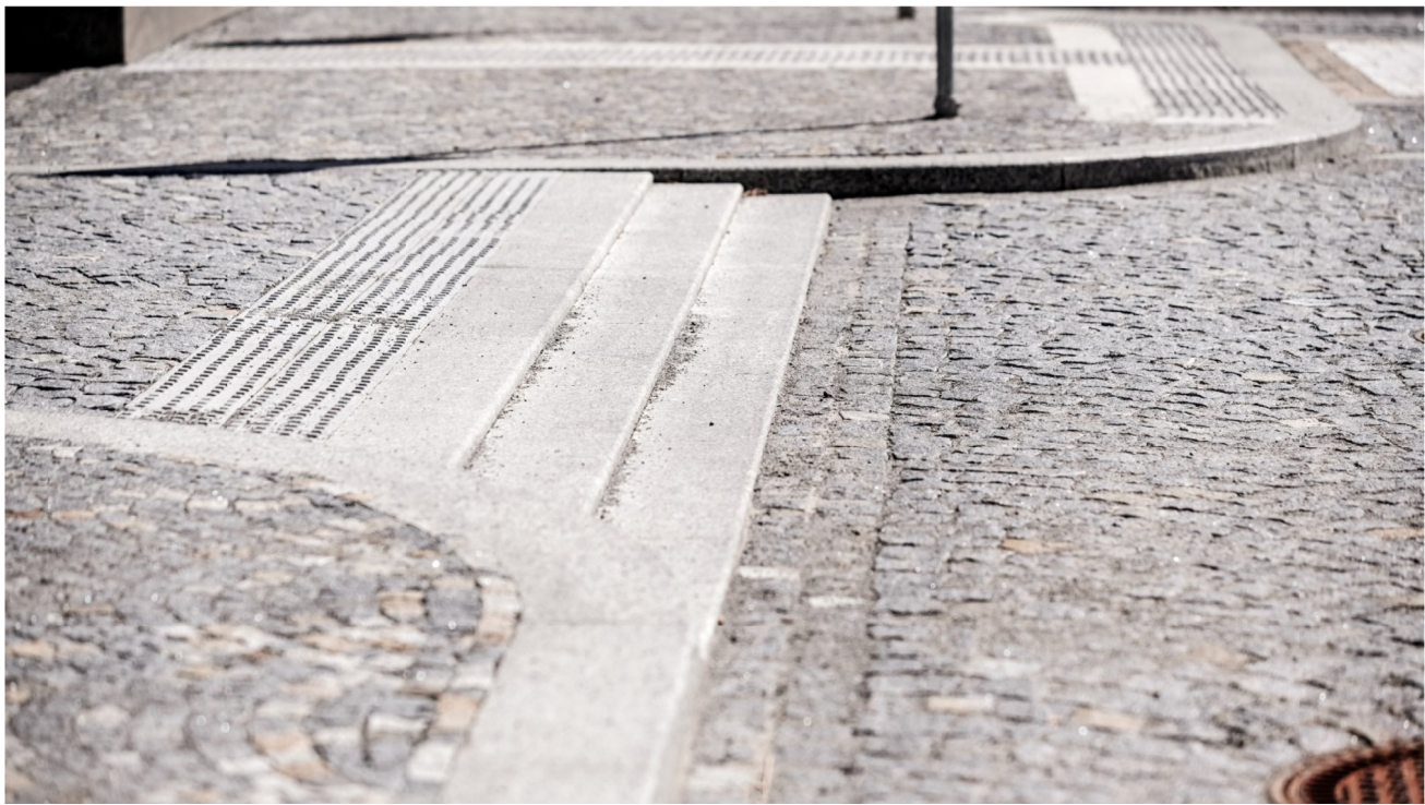
nájezd na zvýšený zpomalovací práh s přechodem pro chodce / přejezdem pro cyklisty; nájezd je tvořen několika příčnými žulovými obrubníky; toto řešení přispívá ke zklidnění dopravy v ul. Cacovická, usnadňuje pohyb cyklistů a pěších a vytváří kultivovaný architektonický detail; příklad řešení: Žďár nad Sázavou, ČR
