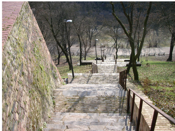
"stupně na terénu" - krátká zkratka svahem s několika lavičkami a s výhledem do údolí Svitavy; stupně vytvářejí pobytové / odpočinkové místo uprostřed svahu; šířka stupňů 2 m, postranní vyhlídkové podesty s dřevěnými lavičkami
