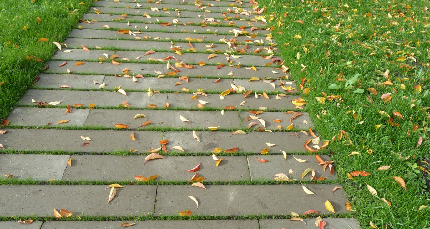
betonové pásky se zatravněnou spárou
