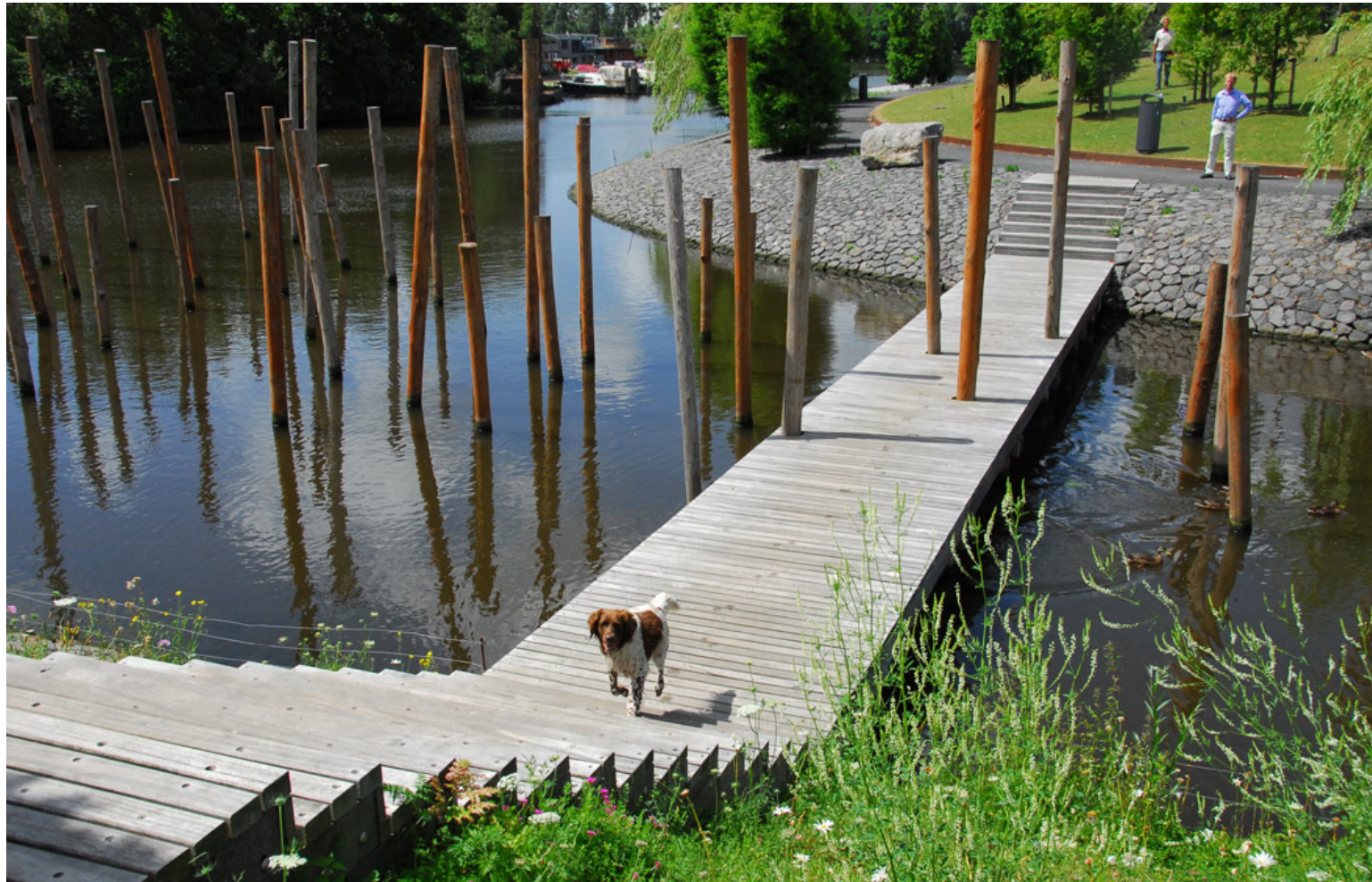
lávka přes vodní tok
