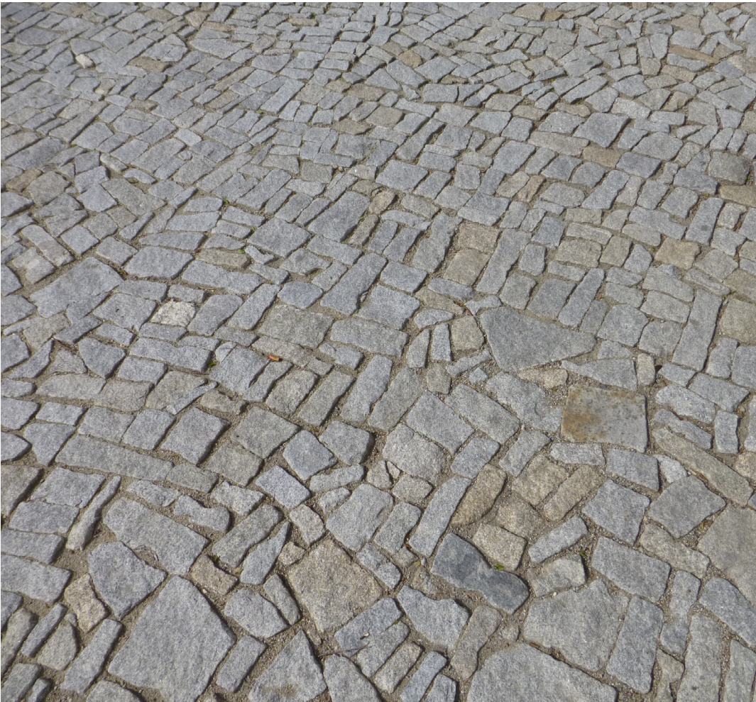
kamenná dlažby - žulové odseky
