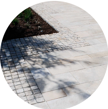
Betonová dlažba s lemováním ze žulové kostky
